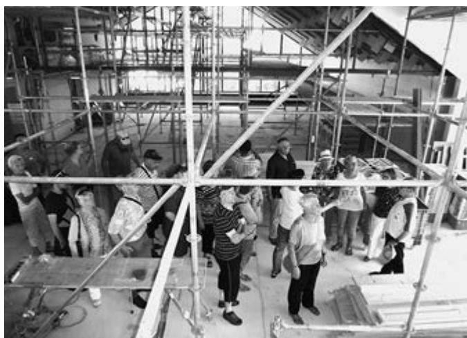
Der grosse Saal im 1. Stock erhält eine neue und helle Decke.
