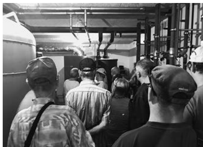
Reges Interesse an der neuen Heizungsanlage.
