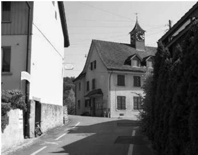
Altes Schulhaus mit Türmchen
