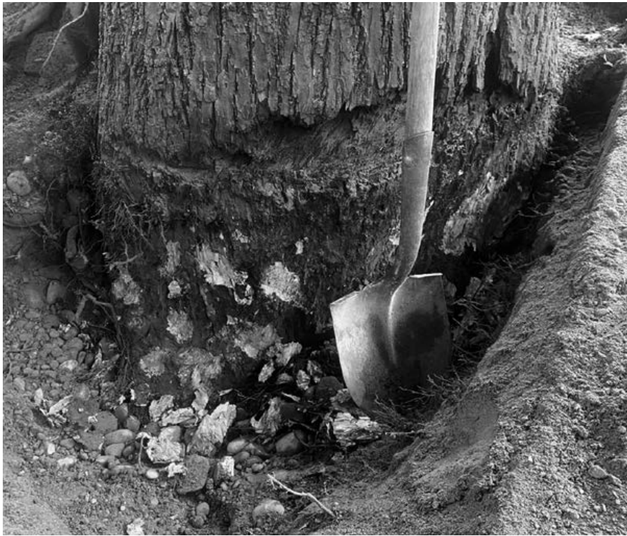
Infolge Aufschüttung befand sich der Wurzelansatz 30 cm unter Bodenniveau, Sauerstoffmangel war die Folge. (Foto: Stadtgrün)
