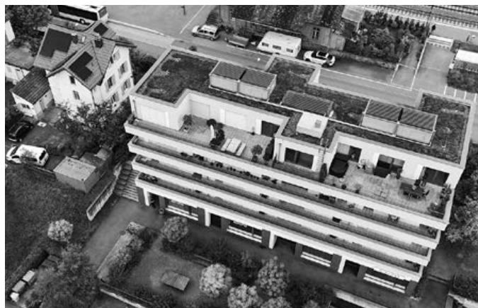
Hauptsitz mit einer PV-Anlage nebenan, welche durch uns gebaut wurde.
